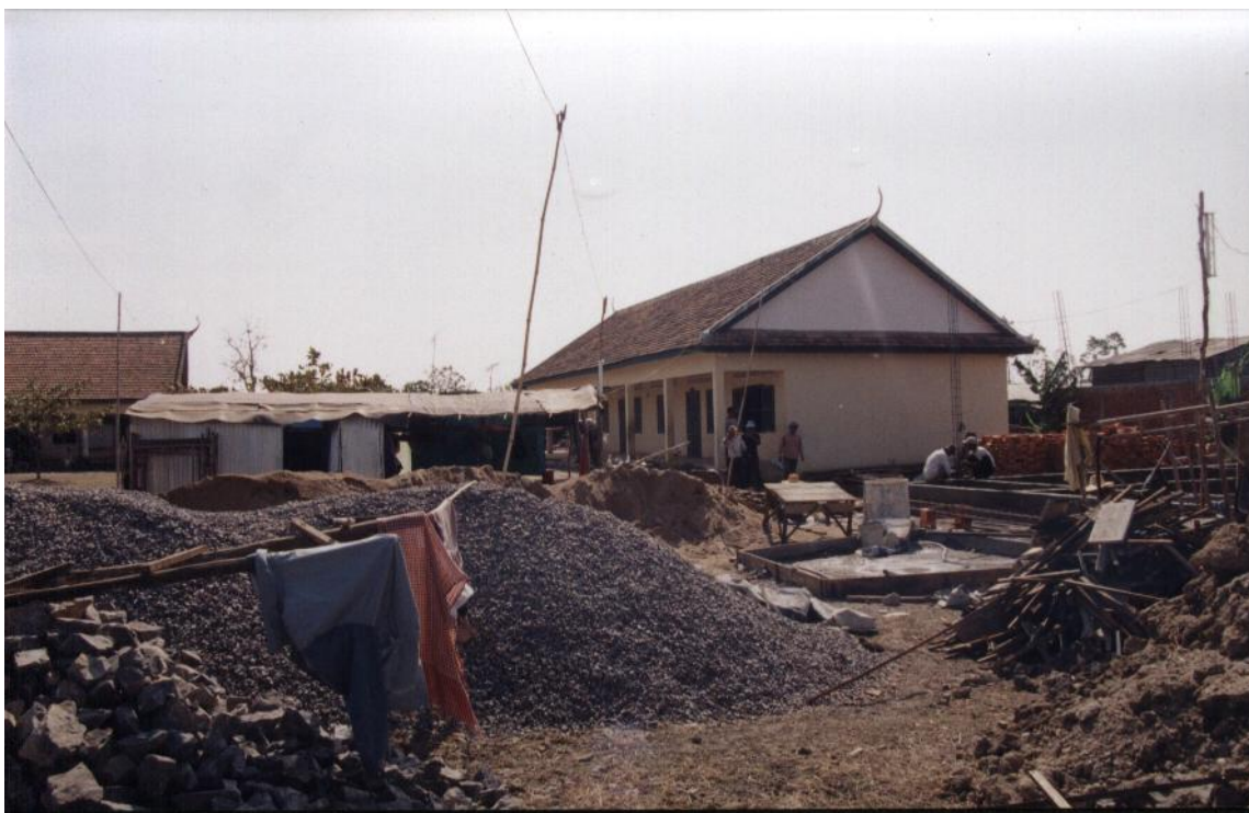
Le chantier lors de la construction du nouveau bâtiment (photo prise en décembre 03)
